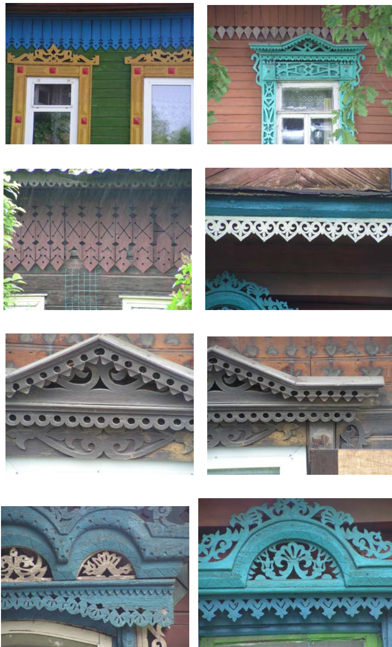
Рис. 5. Виды современной декоративной домовой резьбы ареала между Верхней Волгой и Верхней Сухоной.
