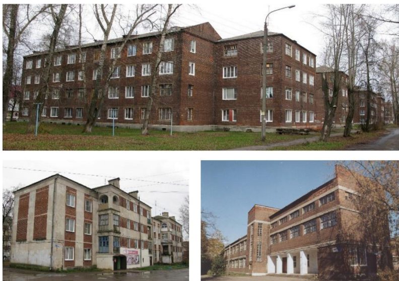
Рис. 2. Жилые и общественные здания соцпоселков 1920-х гг. при новых промышленных предприятиях
