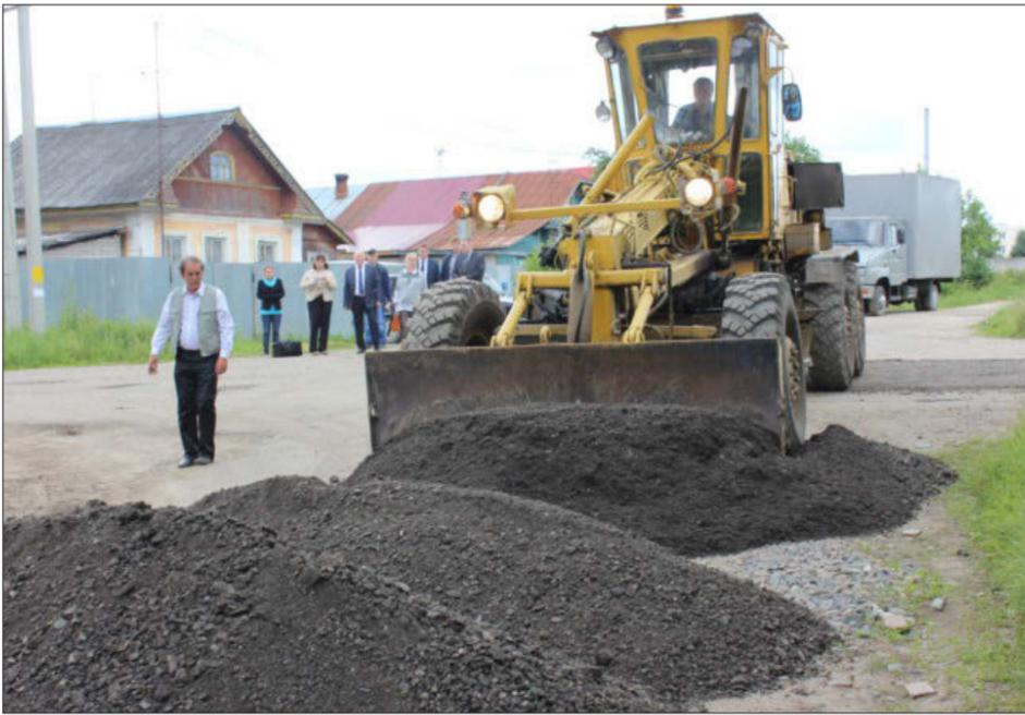
В Иванове асфальтобетонная крошка используется для отсыпки дорог в частном секторе уже много лет. Материал небезупречен – но это лучше, чем ничего. Крошку разравнивают, уплотняют – и в течение нескольких сезонов она служит неплохим покрытием.
